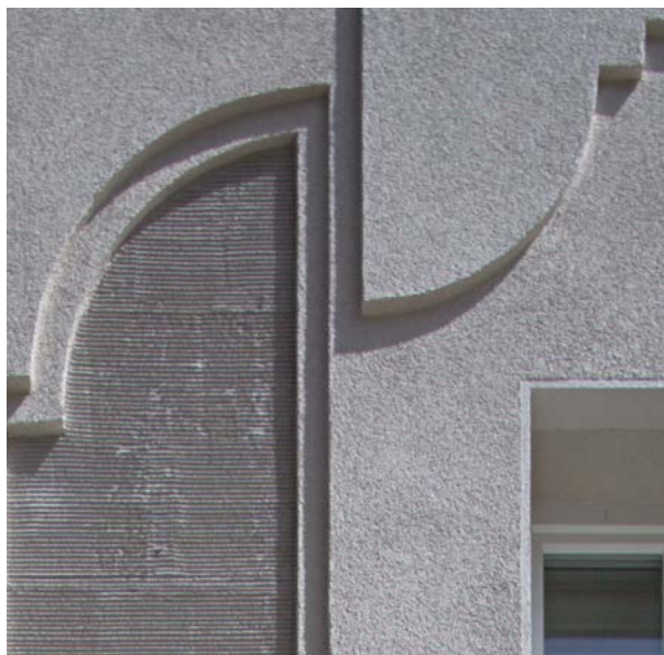
Bei dieser Fassade mit WDVS wurden Putzornamente aufgebracht.
