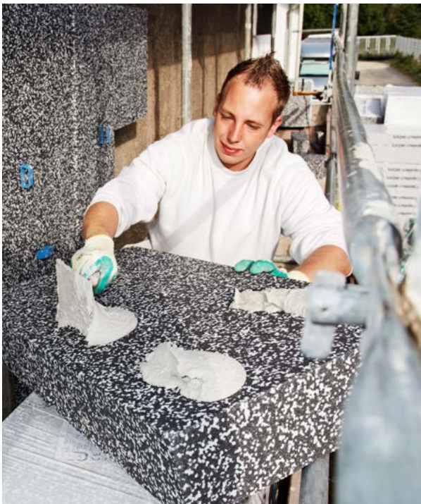
Anbringung einer Polystyrolplatte.
