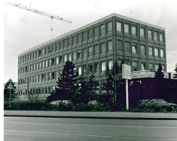
Kreishausnebenstelle in Gronau
