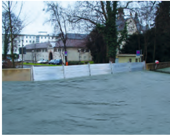
Mobiler Hochwasserschutz mit Dammbalken
