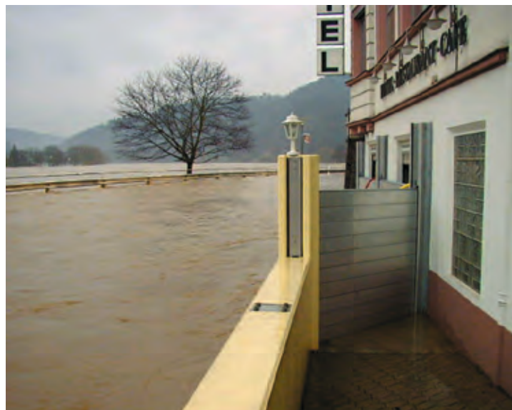
Umlaufender Hochwasserschutz mit teilmobilen Schutzelementen
