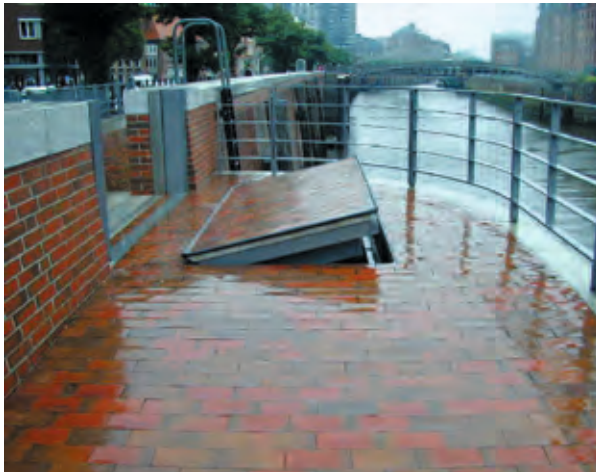
Integrierte Hochwasserschutzklappe
