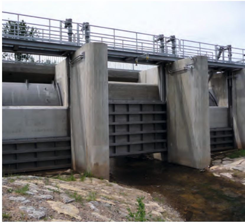
Verschlussbauwerk eines Hochwasserrückhaltebeckens
