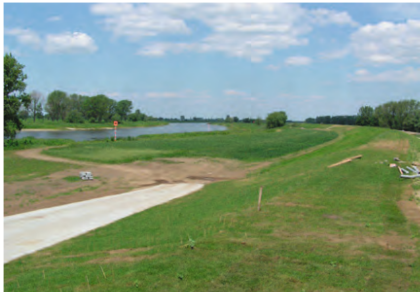
Hochwasserschutzdeich an der Elbe
