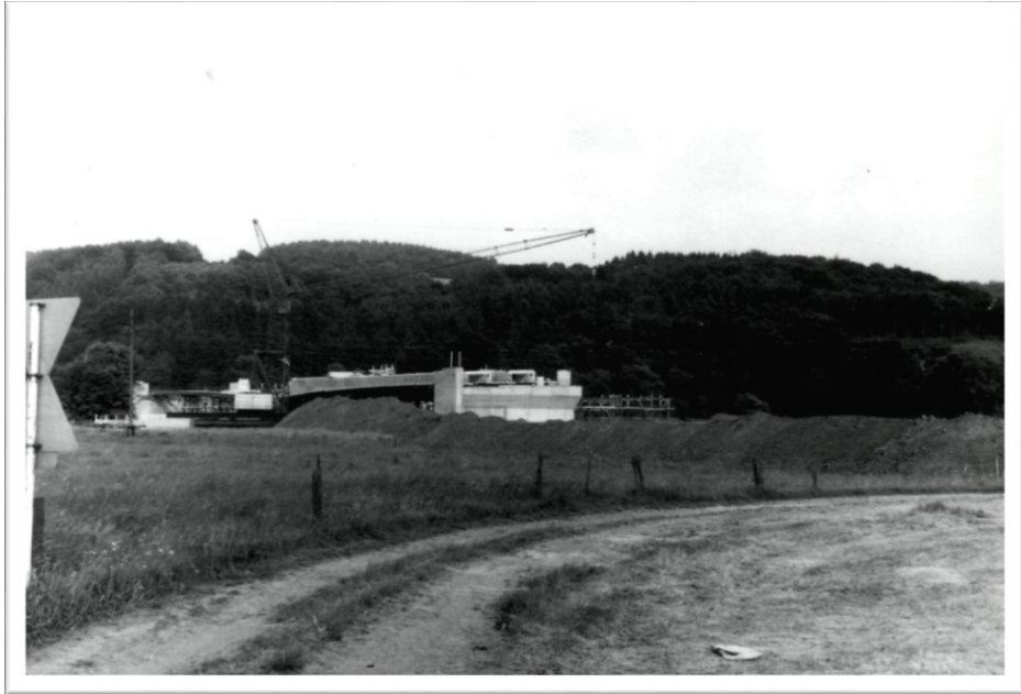
Abbildung 4: Autobahnbrücke Overath Bernsau (1973), Kreisarchiv
