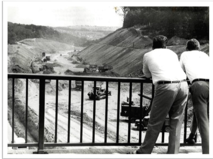
Abbildung 2: Bau der Autobahn A4 Teilstück Untereschbach / Steinhaus (1973), Kreisarchiv Best. 300 Fo 534
