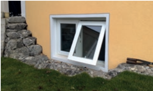
26 Druckwasserdichte Fenster
