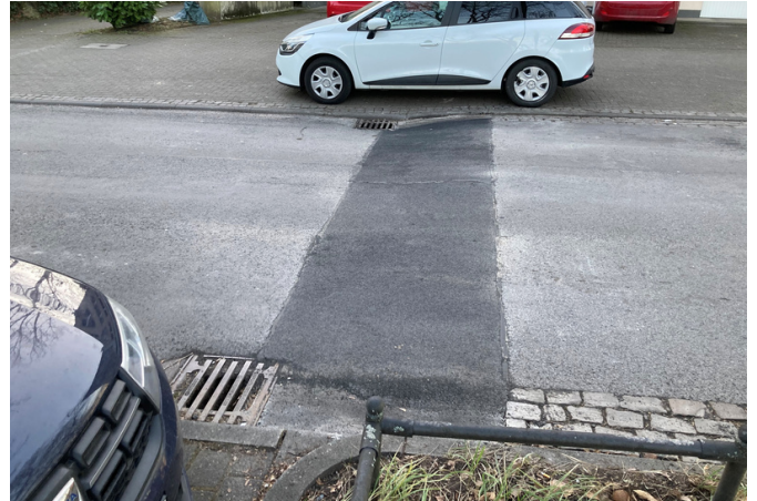
Aufpflasterung auf der Düsseldorfer Straße nach der Umgestaltung.
